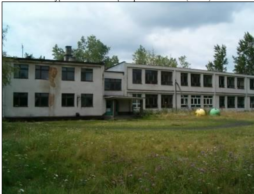
Zdjęcie 20 Szkoła w Sędku przed remontem (2003r.)
