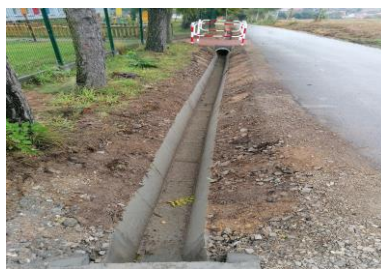
Wykonanie rowu w msc. Zamkowa Wola
