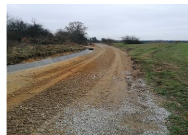
Wykonanie rowu odwadniającego przy drodze wewnętrznej w msc. Ruda.
