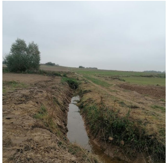
Odcinek nr 1 po pracach
