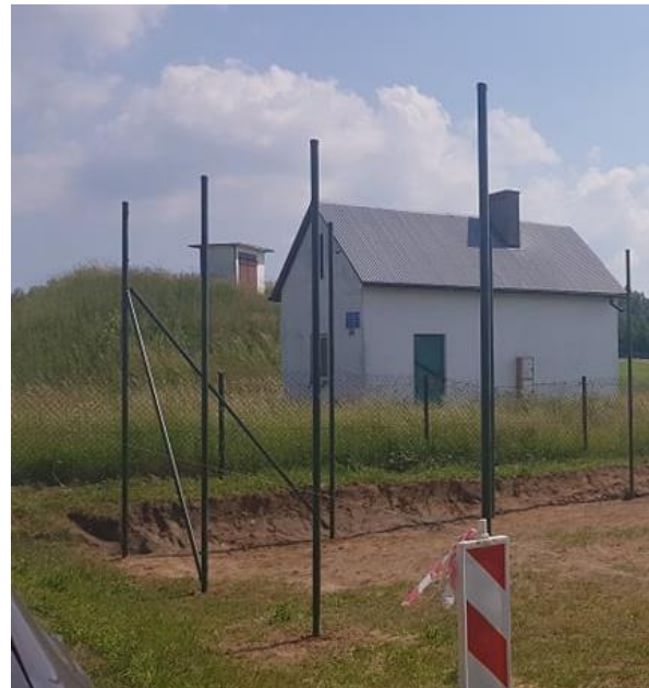
budowaliśmy ogrodzenie przy boisku szkolnym w Lechówku
