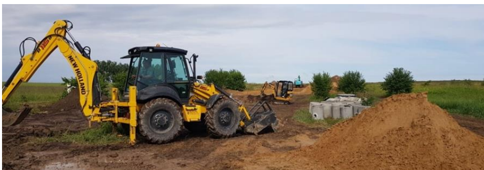
realizowaliśmy roboty budowlane przy uzbrojeniu działek nr 727/... w Łągowie (wodociąg, kanalizacja sanitarna i kanalizacja deszczowa).
