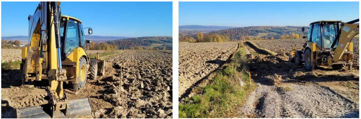
Przebudowa drogi dojazdowej do gruntów rolnych w msc. Wola Łągowska – Duraczów
