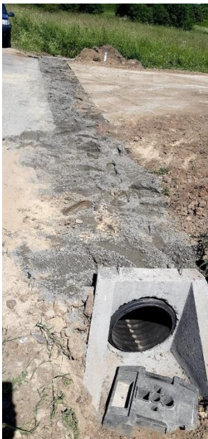
Montaż przepustu w msc. Łągów, ul. Źródłowa
