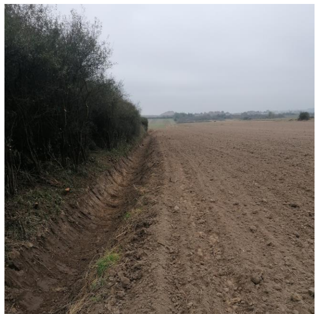
Odcinek nr 2 po pracach
