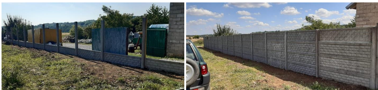
wykonaliśmy ogrodzenie przy świetlicy wiejskiej w Nowym Stawie
