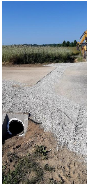
Montaż przepustu w msc. Łągów, ul. Źródłowa
