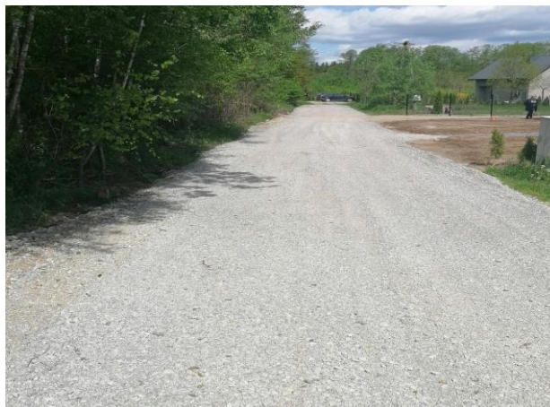
Droga po pracach
