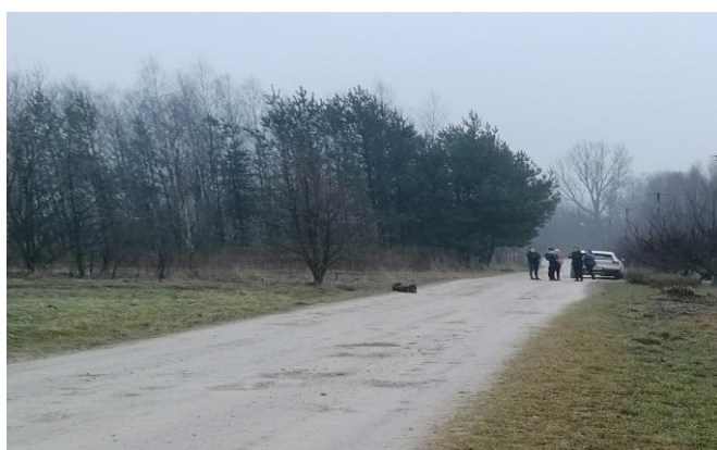
Droga przed pracami
