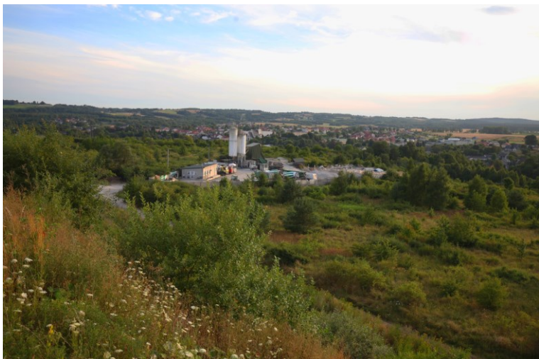
Fotografia 5. Betoniarnia Łagów w sąsiedztwie projektu planu [fot. Kama Kotowicz, lipiec 2020 r.]
