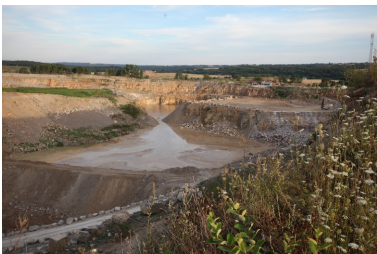
Fotografia 4. Tereny objęte projektem planu zlokalizowane są w bezpośrednim sąsiedztwie terenów przekształconych przemysłowo [fot. Kama Kotowicz, lipiec 2020 r.]
