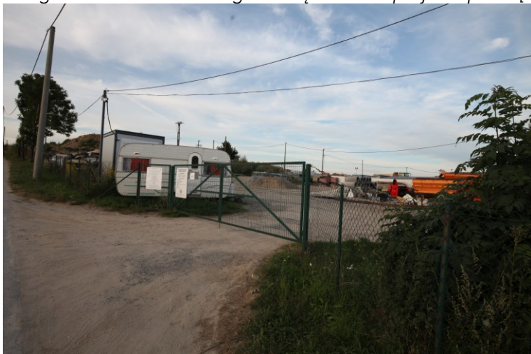
Fotografia 6. Punkt Selektywnej Zbiórki Odpadów Komunalnych w sąsiedztwie planu [fot. Kama Kotowicz, lipiec 2020 r.]
