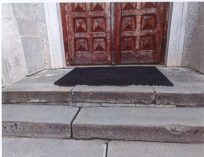
Zdj. Nr 21. i Nr 22. Uszkodzenia i deformacje schodów ( Źródło: materiały własne Zespołu opracowującego PFU)
