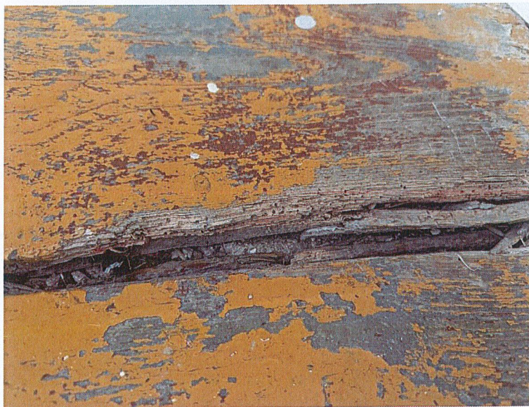
Zdj. Nr 3. Widok na ubytki i deformacje desek. ( Źródło: materiały własne Zespołu opracowującego PFU)
