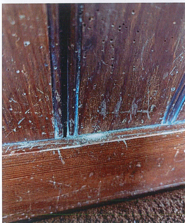
Zdj. Nr 17, 18. Widok na ubytki powłok i ślady bytowania szkodników w materiale. ( Źródło: materiały własne Zespołu opracowującego PFU)
